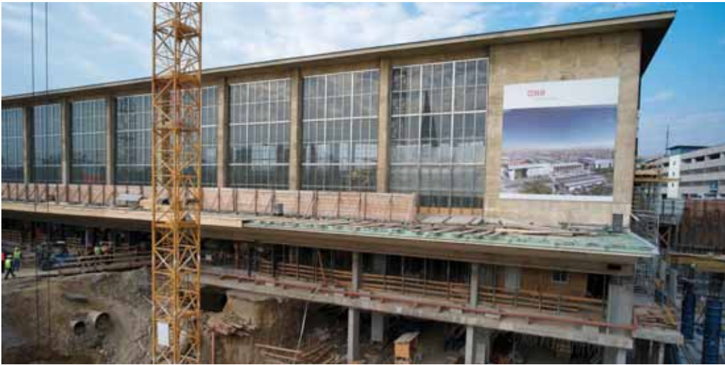
Die denkmalgeschützte Halle des Wiener Westbahnhofs wird gerade saniert. 2011 soll die Halle gemeinsam mit den Büro- und Hotelzubauten als neue „Bahnhofcity“ (Pläne von Neumann und Partner) eröffnet werden.
