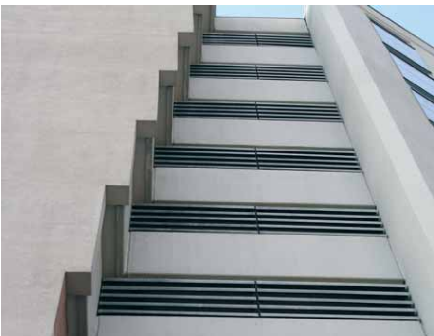
Fassadendetail des Olof Palme Hofes
