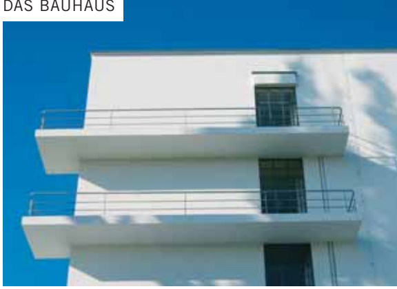
oben: Das Prellerhaus, das älteste Campus-Gebäude in Weimar. Die Sanierung wurde 2008 abgeschlossen.
