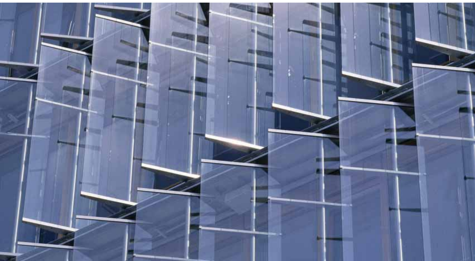
Doppelfassade am Beispiel Justizanstalt in Leoben nach Plänen von Architekt Josef Hohensinn (s. auch Foto rechts unten)
