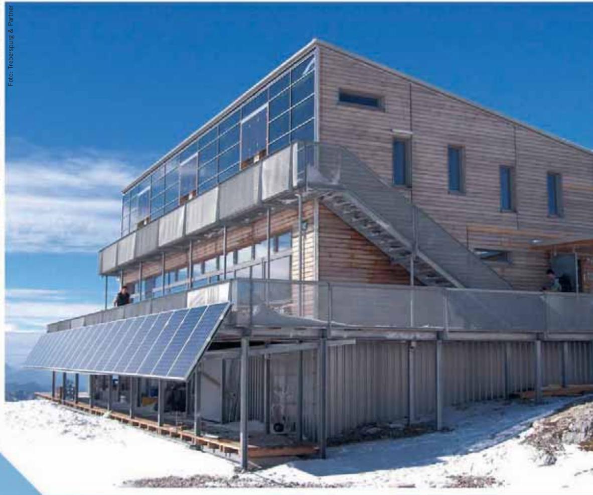
Schiestlhaus – energieeffiziente Schutzhütte: pos Architekten, Treberspurg & Partner; Statik: Robert Salzer
